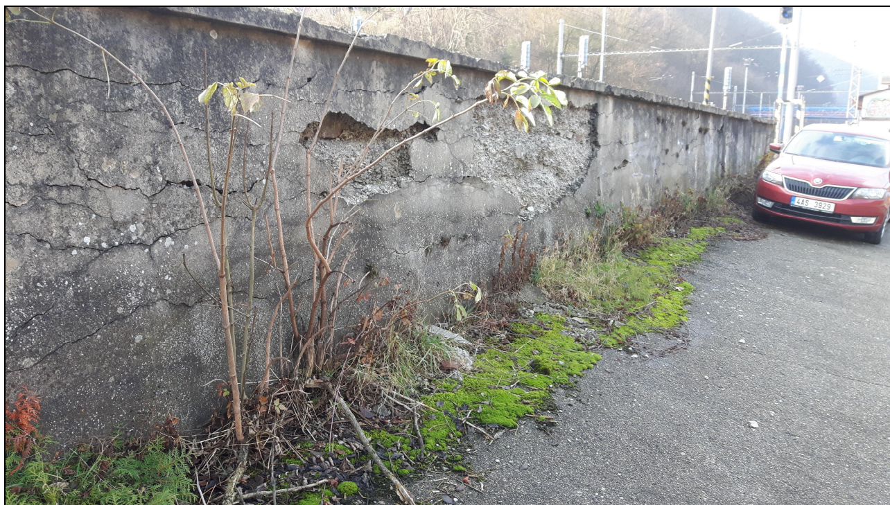
Obr. č. 9 – Zed' z monolitického betonu (hloubková degradace betonu, trhliny v betonu)
