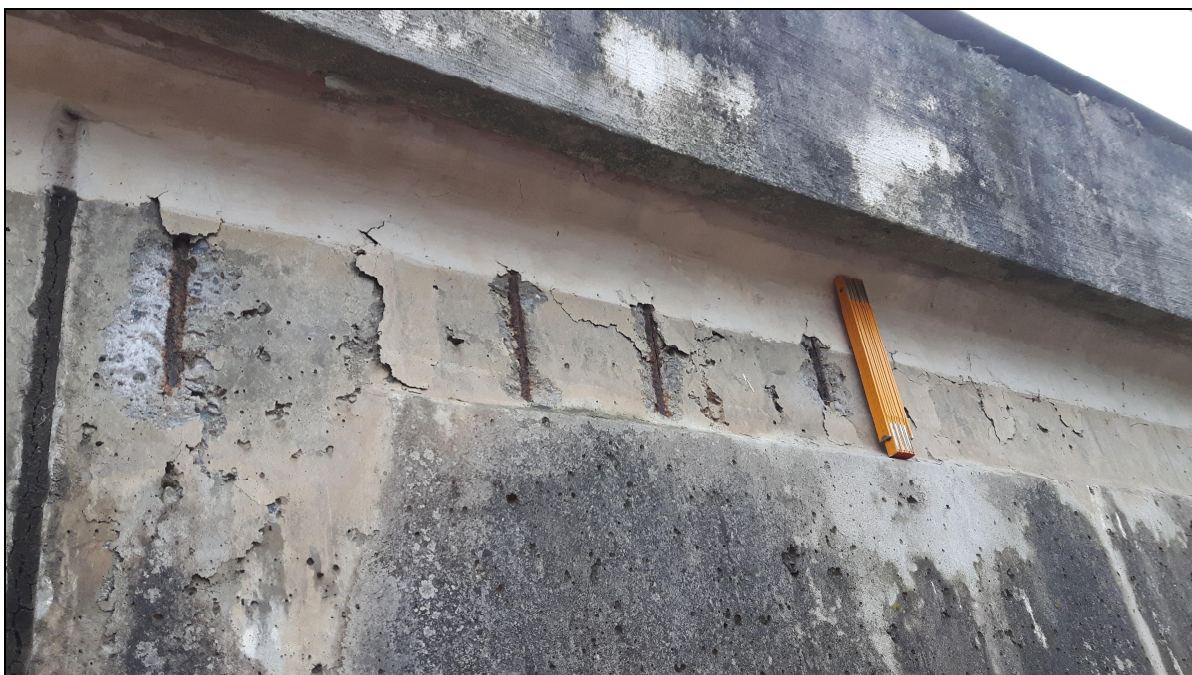
Obr. č. 12 – Část z dílců z prefabrikovaného betonu, povrchové poškození – odprysky
