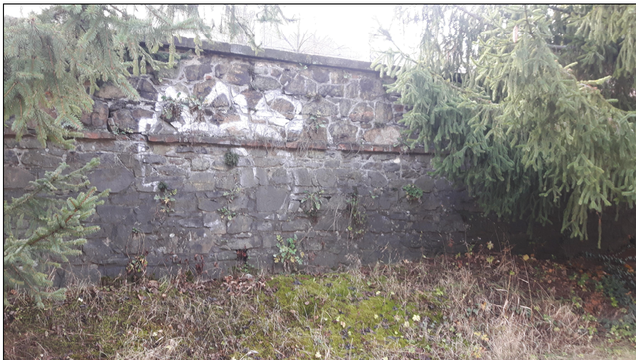
Obr. č. 6 – Zeď z kamenného zdiva (granodiorit) – 2. část
