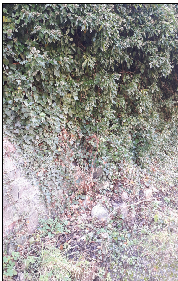
Obr. č. 10 – Zed' z kamenného zdiva – kontakt pískovcové a granodioritové části, částečná destrukce zdi (vypadané zdící kameny, degradace pojiva a rozvolnění zdi způsobené vegetací)
