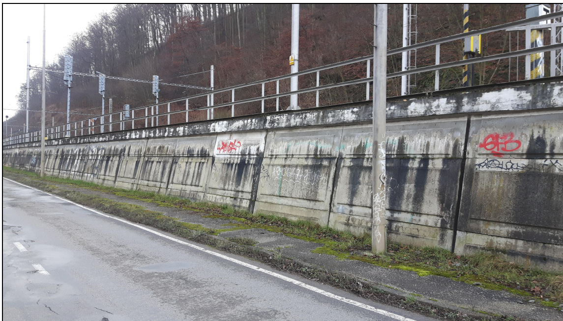
Obr. č. 9 – Část z dílců z prefabrikovaného betonu, 4. úsek – tato část bude cca od odjezdových návěstidel odstraněna a nahrazena novou opěrnou zdí (SO 15-19-14)
