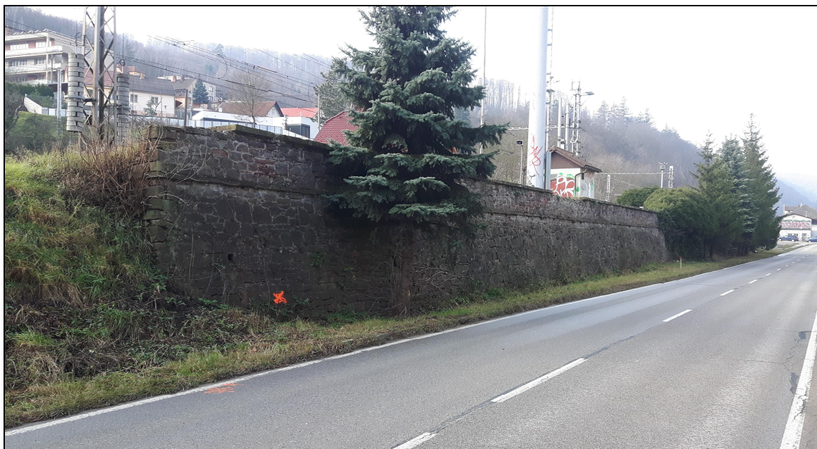
Obr. č. 1 – Celkový pohled na část z kamenného zdiva tvořenou pískovci a prachovci
