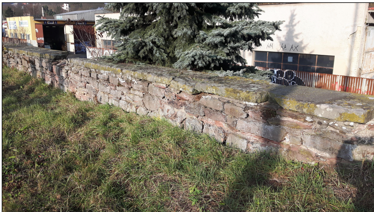
Obr. č. 14 – Zeď z kamenného zdiva (prachovce, pískovce) – pohled z kolejiště (degradace spárování a pojiva, zvětrání zdících kamenů)
