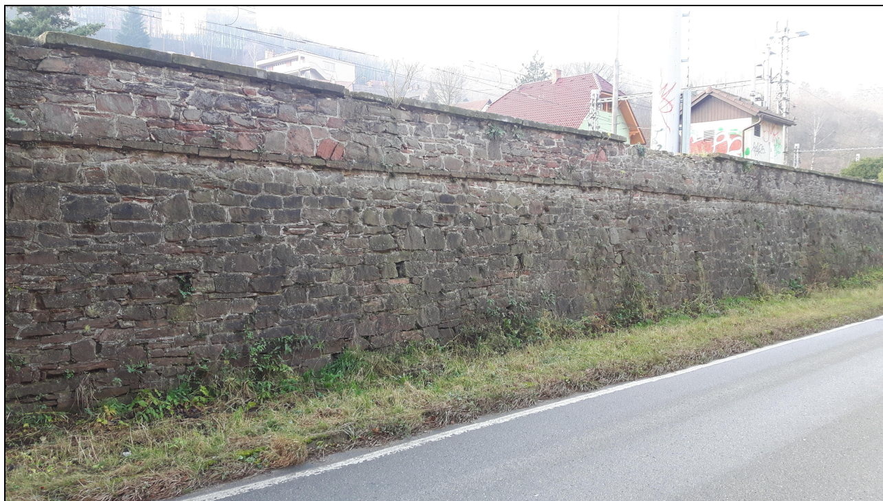
Obr. č. 3 – Zed' z kamenného zdiva (pískovce, prachovce) – 2. část (degradované spárování)
