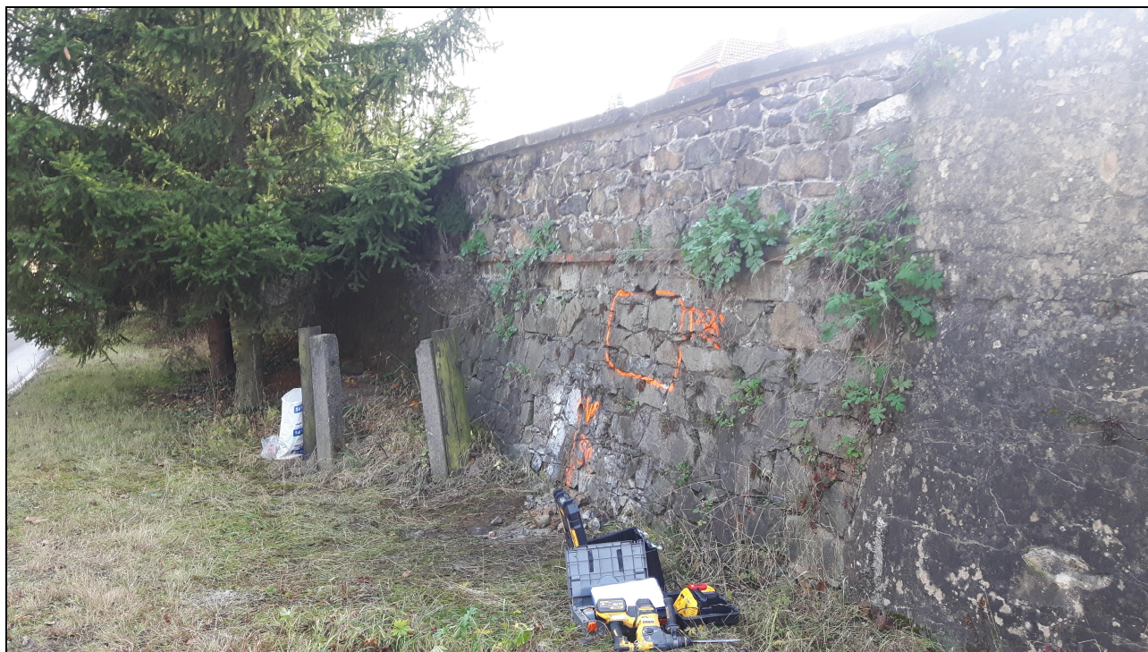
Obr. č. 7 – Zed' z kamenného zdiva (granodiorit) – 3. část (degradované spárování), napojení monolitické části
