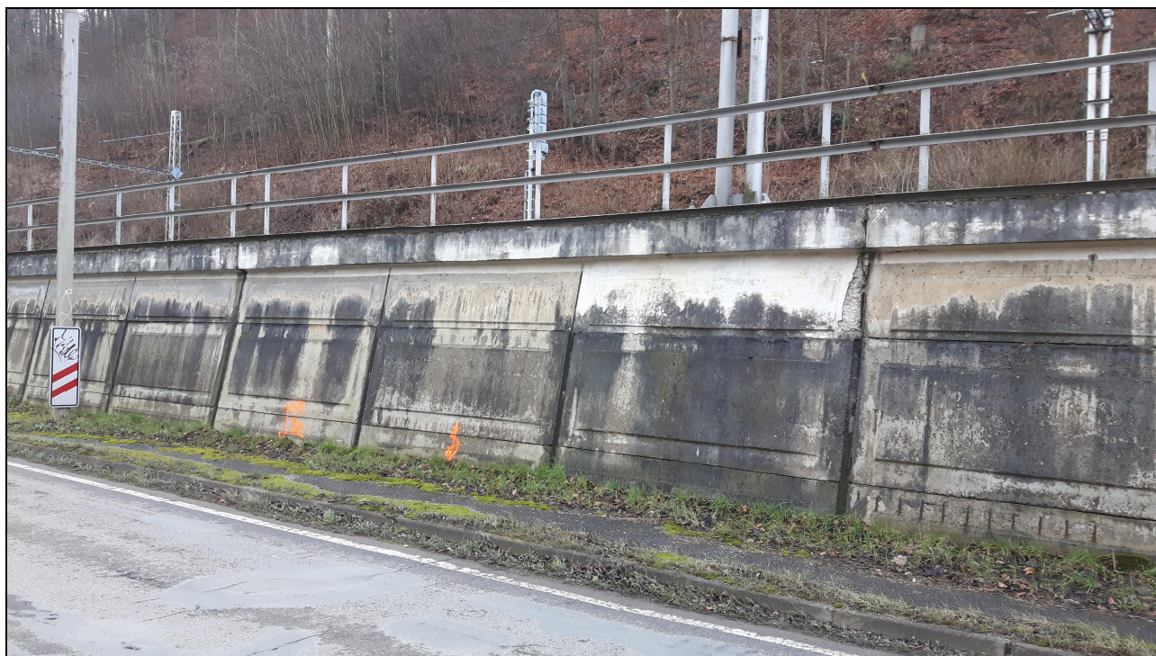
Obr. č. 7 – Část z dílců z prefabrikovaného betonu, 2. úsek
