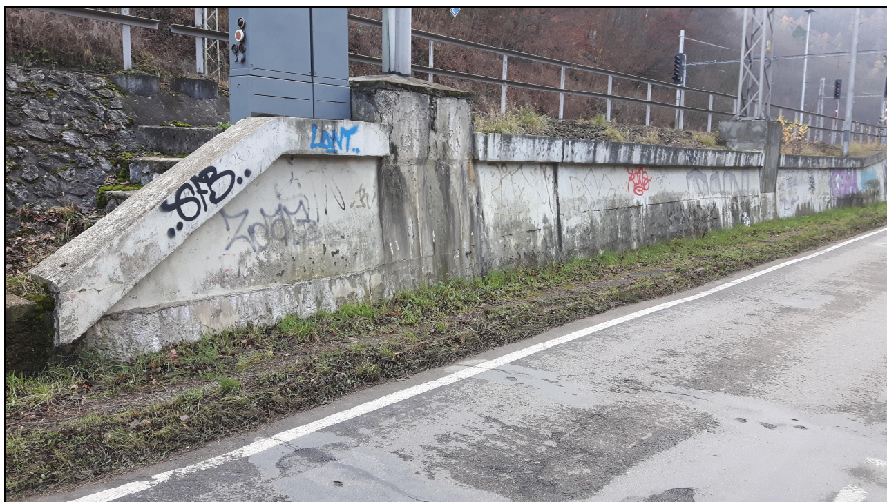
Obr. č. 2 – Část z monolitického betonu, 1. a 2. dilatační úsek
