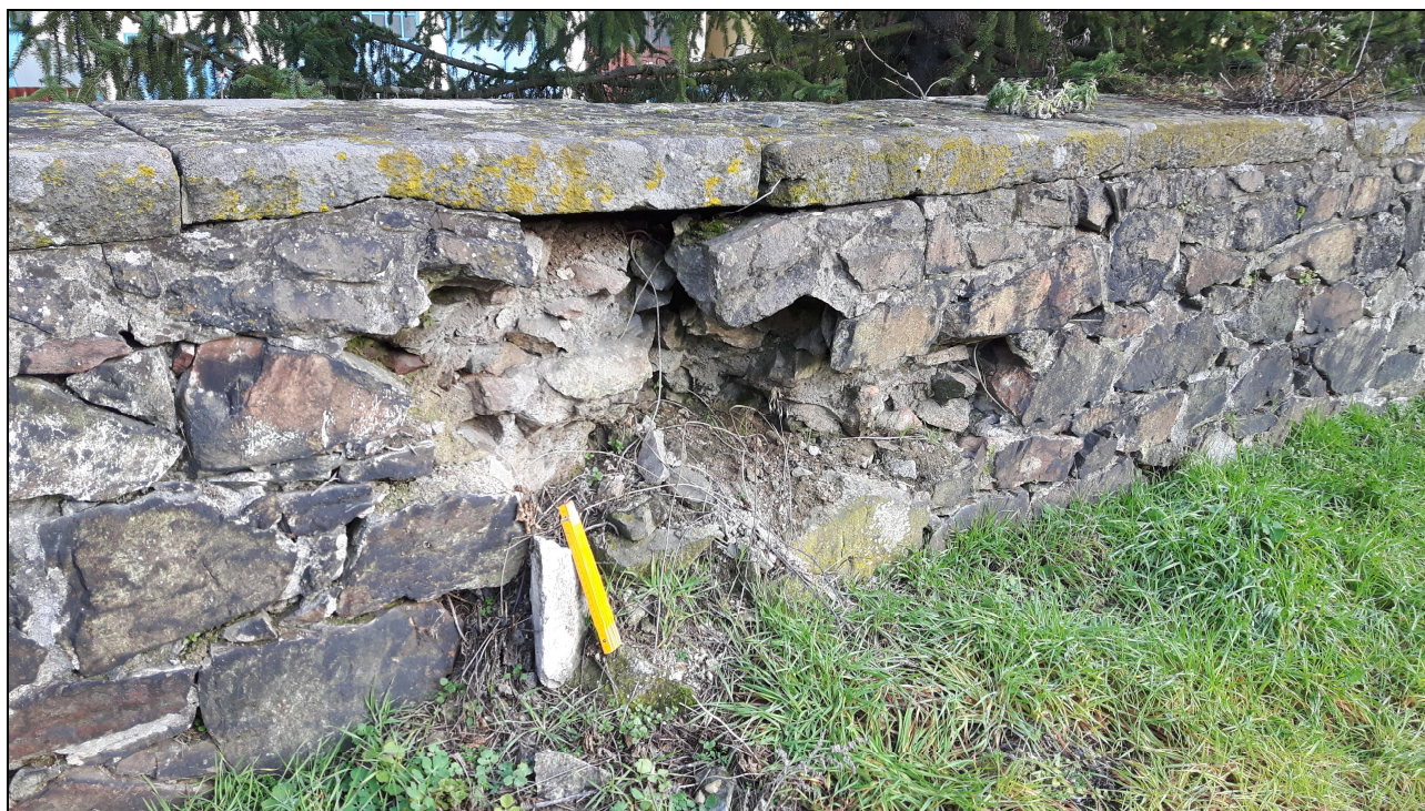
Obr. č. 12 – Zed' z kamenného zdiva (granodiorit) – pohled z kolejiště (degradace spárování a pojiva, částečná destrukce zdi)
