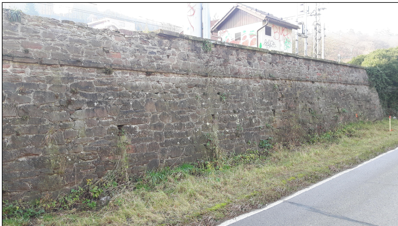
Obr. č. 4 – Zed' z kamenného zdiva (pískovce, prachovce) – 3. část
