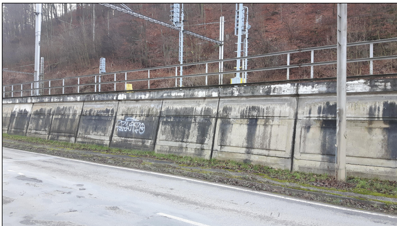
Obr. č. 8 – Část z dílců z prefabrikovaného betonu, 3. úsek
