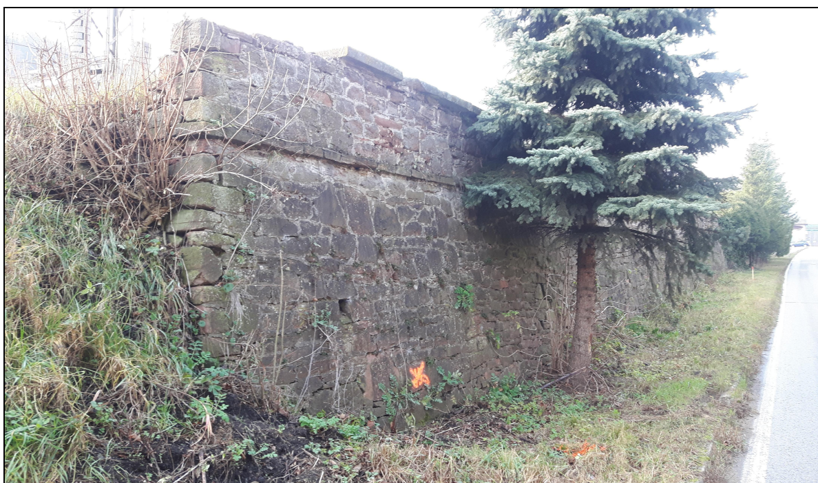
Obr. č. 2 – Zeď z kamenného zdiva (pískovce, prachovce) – 1. část (degradované spárování a pojivo, rozvolněné zdící prvky)
