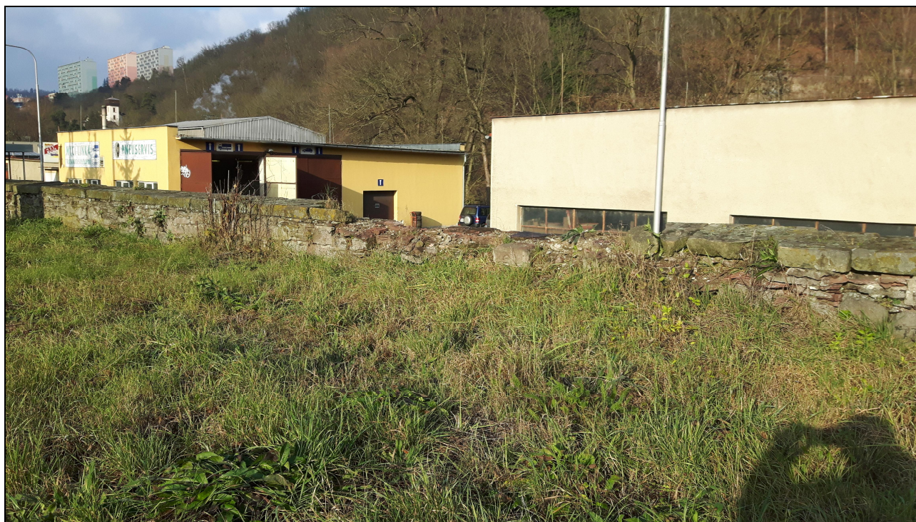
Obr. č. 13 – Zeď z kamenného zdiva (prachovce, pískovce) – pohled z kolejiště (degradace spárování a pojiva, zvětrání a rozpad zdících kamenů)
