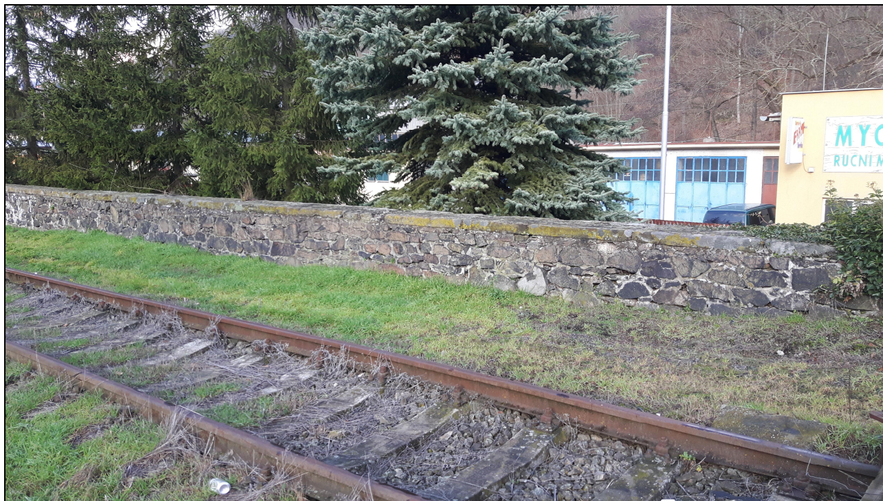
Obr. č. 11 – Zed' z kamenného zdiva (granodiorit) – pohled z kolejiště (degradace spárování)
