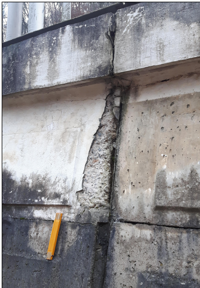
Obr. č. 11 – Pohled na dřík prefabrikované části, povrchové poškození prefa dílců
