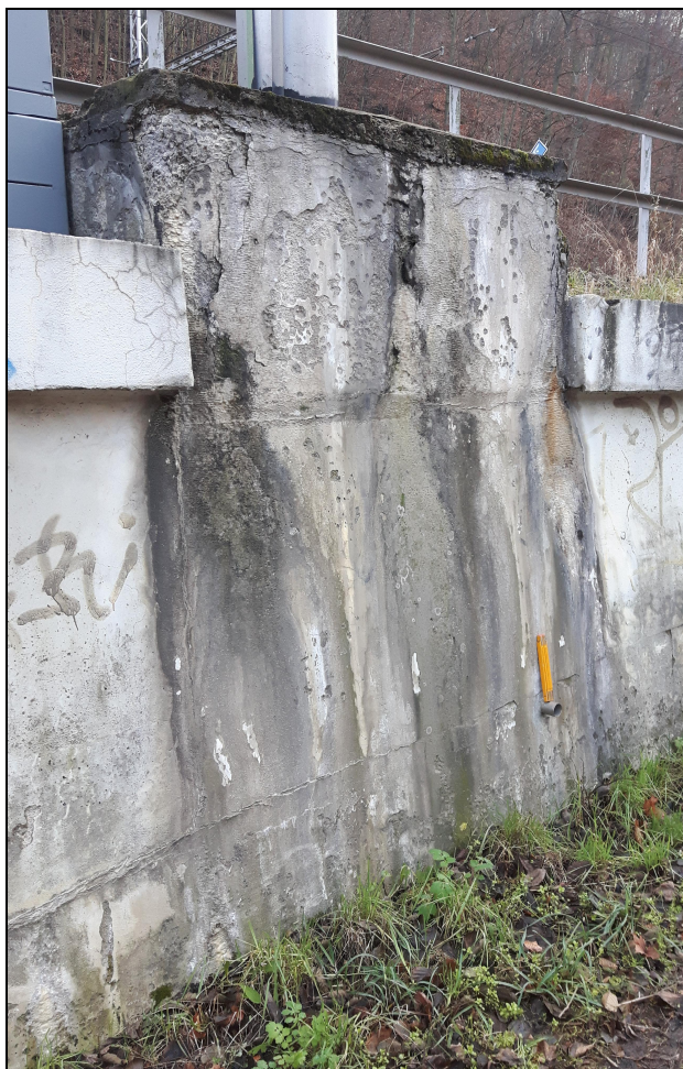
Obr. č. 10 – Část z monolitického betonu – degradace povrchových vrstev u patky trakčního stožáru
