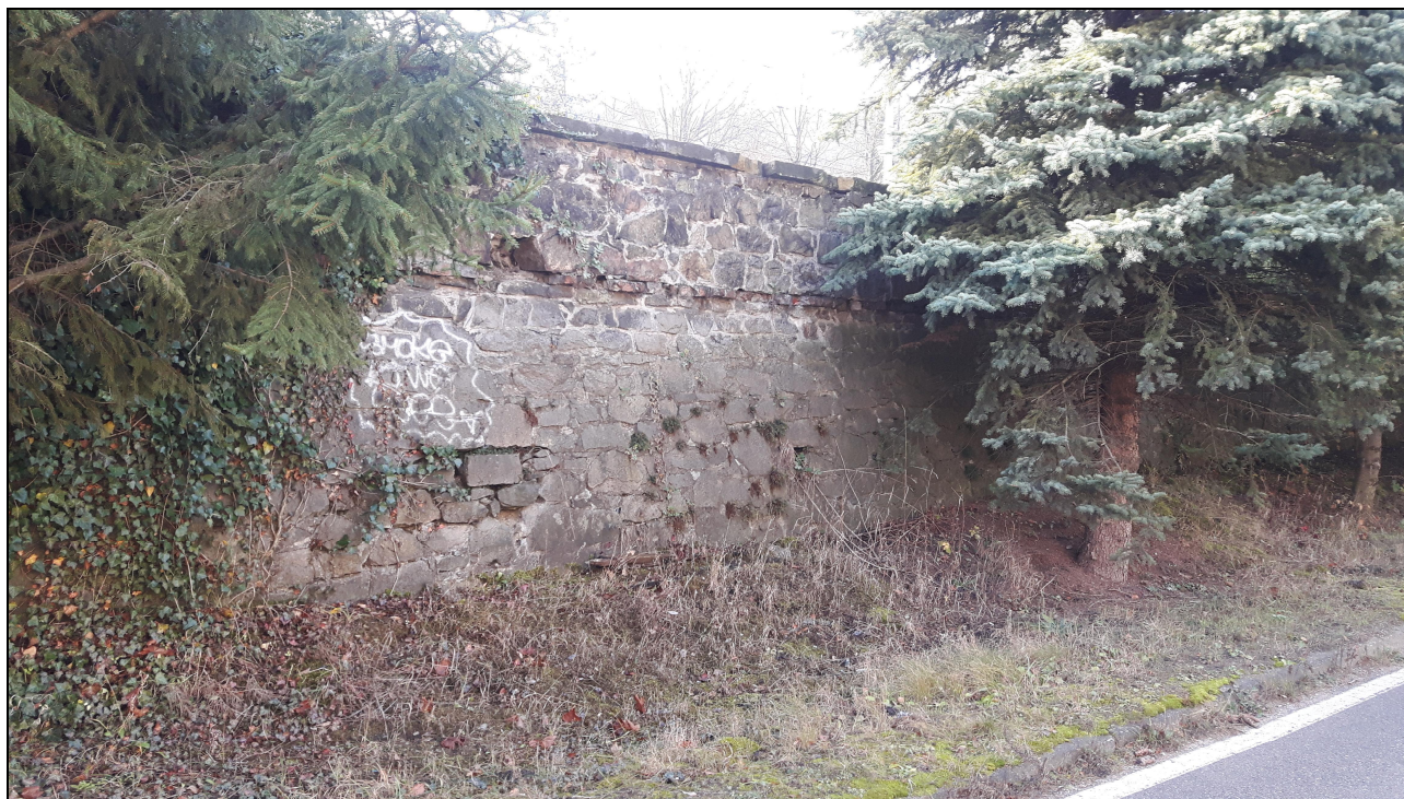
Obr. č. 5 – Zeď z kamenného zdiva (granodiorit) – 1. část (degradované spárování a pojivo, vypadané kameny ze zdiva)
